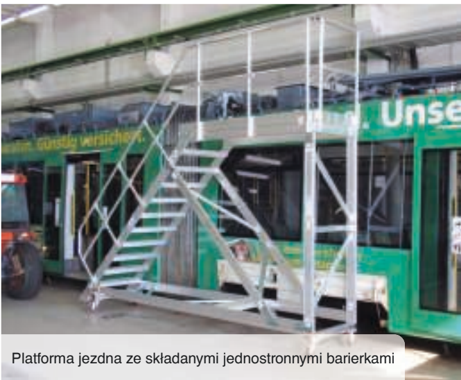
Platforma montażowa jezdna ze składanymi barierkami.
